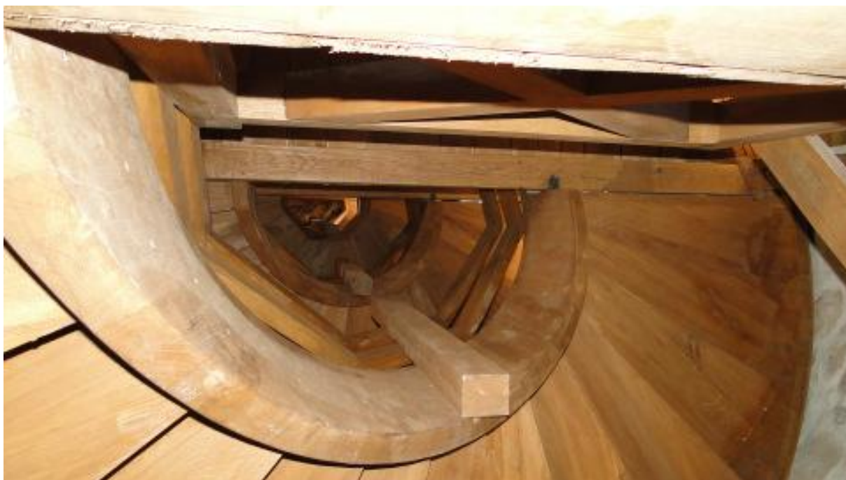
Klatka schodowa w Wieży Baszty Zamkowej. Foto: Krzysztof Tęcza
