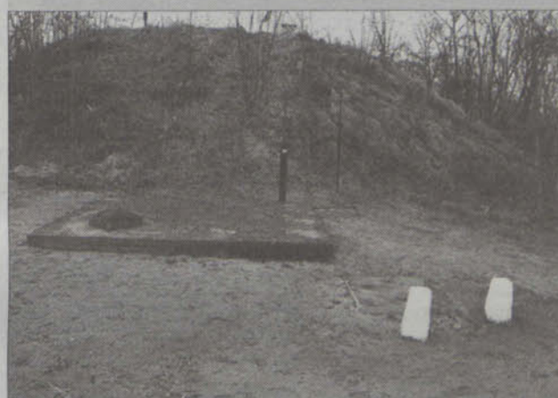
Większa część przepompowni ukryta jest pod ziemią.
