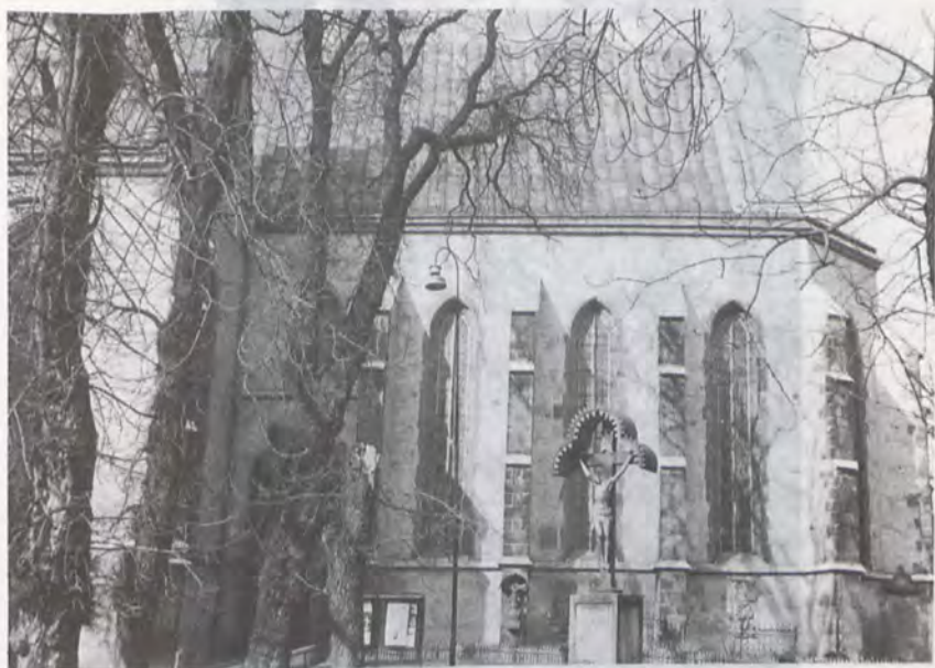
50. Ściana prezbiterium z charakterystycznym rytmem: skarpa-okno-skarpa-okno ...
