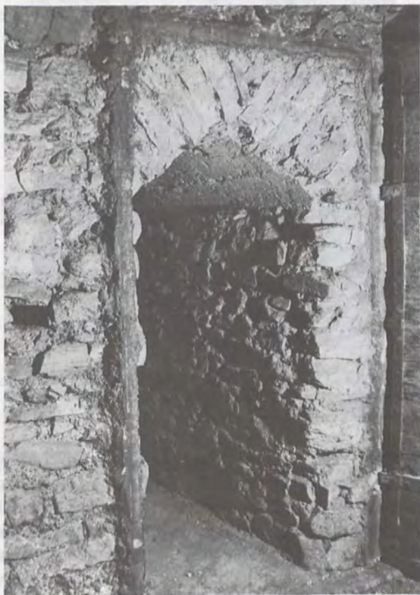
62. Wnętrze wieży kościelnej. Widoczne jest przejście z niższej izby dzwonnika na poddasze nawy północnej
