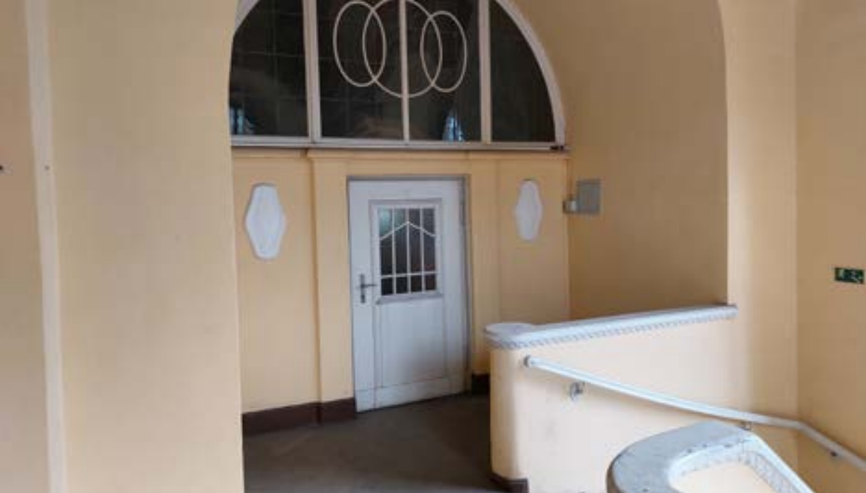
Klatka schodowa prowadząca na empory kościoła po 1909 r.
