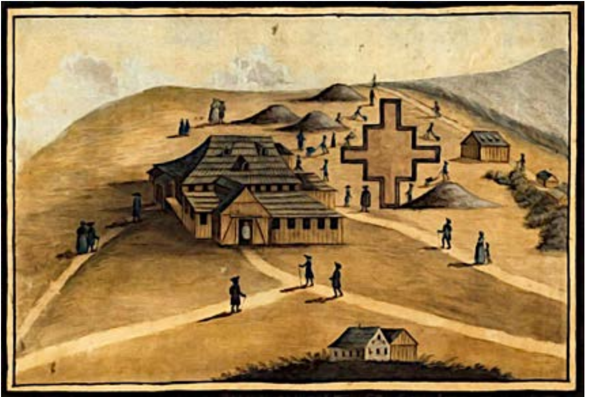
Drewniany kościół – tymczasowy
