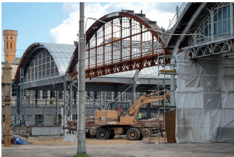
Przebudowa Dworca Głównego we Wrocławiu, fot. Sławomir Najniger
