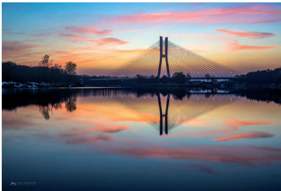
Most Rędziański w ciągu Autostradowej Obwodnicy Wrocławia, fot. Artur Sobolewski
