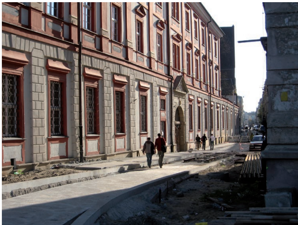
Przebudowa linii tramwajowej na ul. Szewskiej we Wrocławiu, fot. Sławomir Najniger
