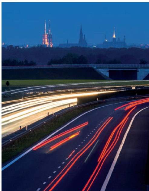
Obwodnica Autostradowa Wrocławia, fot. Artur Sobolewski
