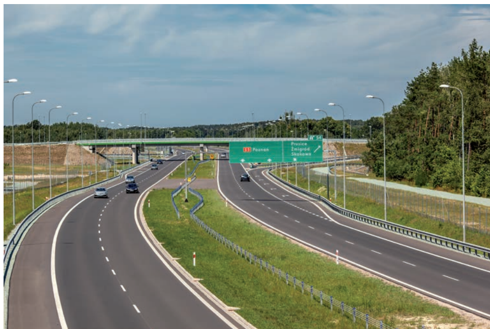
Droga ekspresowa S-5, fot. Urząd Miejski Prusice
