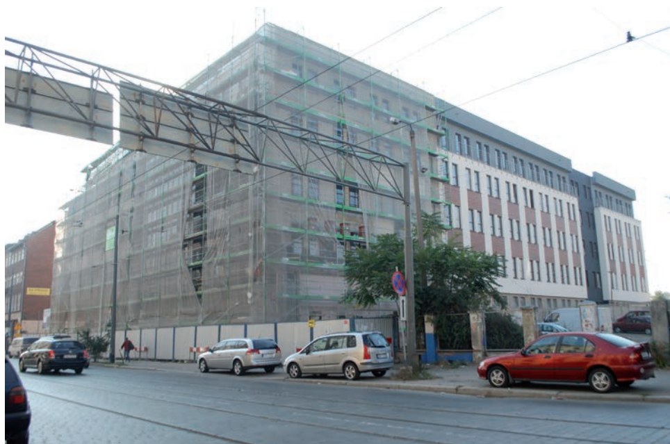
Budowa budynku starostwa powiatowego we Wrocławiu, fot. Sławomir Najniger
