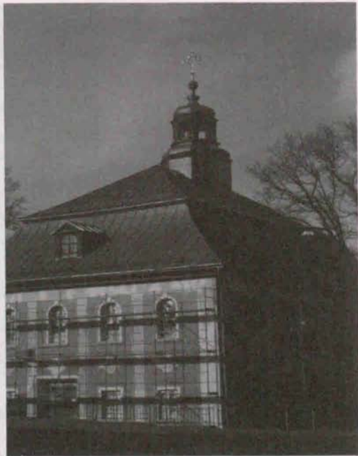
Fot. 6. Prace przy odnowieniu elewacji
