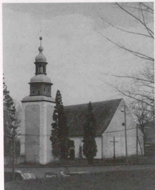
Fot. 1. Kościół pw. św. Marcina, widok od strony zachodniej
