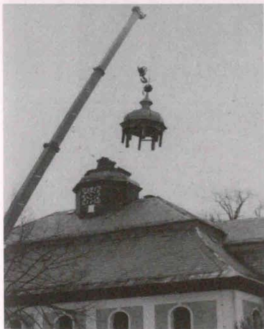
Fot. 1. Demontaż spróchniałej wieży 8 maja 1991. Dźwig z kopalni Turoszów
