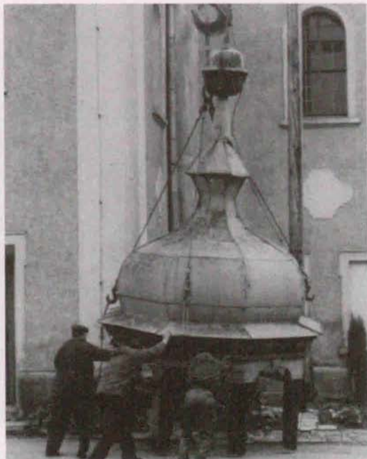
Fot. 2. Demontaż wieży – złożenie na placu kościelnym
