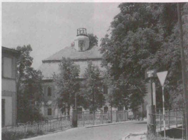
Fot. 4. Etapy prac przy rekonstrukcji wieży
