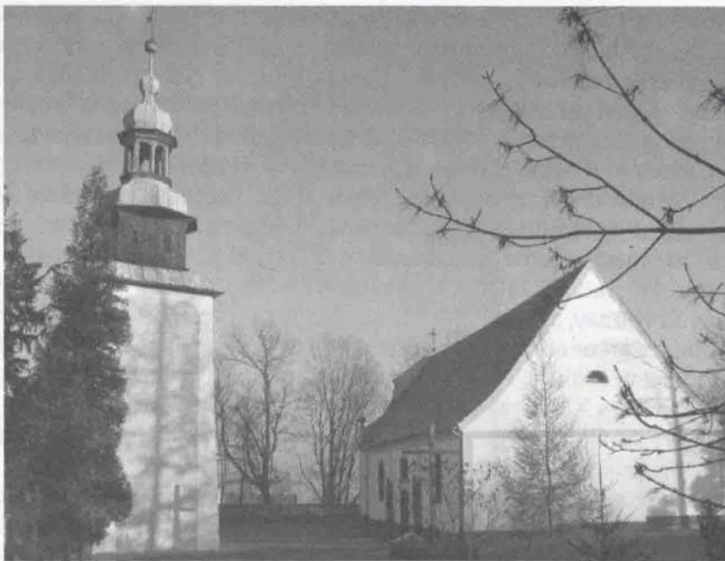
Kościół p.w. św. Marcina - widok od strony zachodniej.
