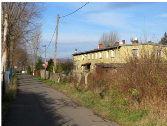
Ilustracja 14: Dwa takie domy znajdziemy przy ul. Mickiewicza w Lubawce; listopad 2017. Czy są to zachowane do dzisiaj budynki pokoszarowe w których mieścił się FAL Liebau?
