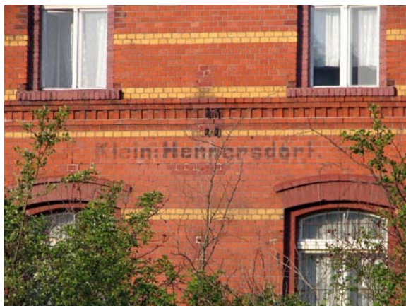
Ilustracja 8: Co ciekawe na zachodniej elewacji budynku dawnej stacji kolejowej w Jawiszowie do czasów współczesnych zachował się niemieckojęzyczny napis Klein Hennersdorf; czerwiec 2005.
