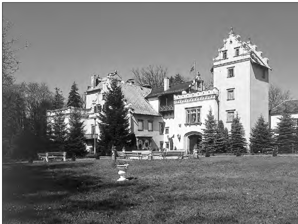
Nowy Dwór od strony parku, 2005 r. fot. K. Sawicki
