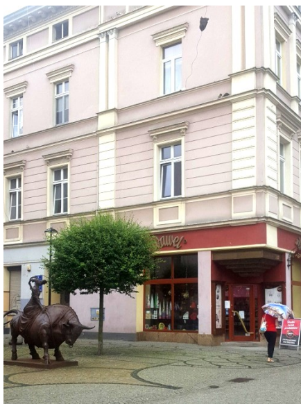
Siedziba Komendy Hufca przy ul. 1 Maja 28 (widoczne cztery okna na pierwszym piętrze), fot. A. S.
