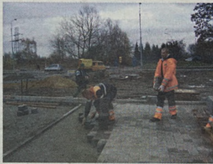
Trwa budowa nowej pętli
