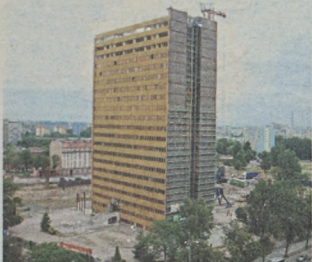
Poltegor od czerwca burzyły koparki od dachu. Oto poszczególne fazy rozbiórki
