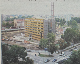
Poltegor od czerwca burzyły koparki od dachu. Oto poszczególne fazy rozbiórki
