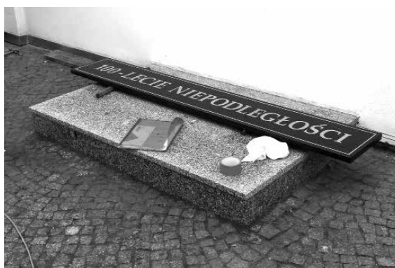
Ryc. 2. Montaż elementów Pomnika Niepodległości, 2018 r.
