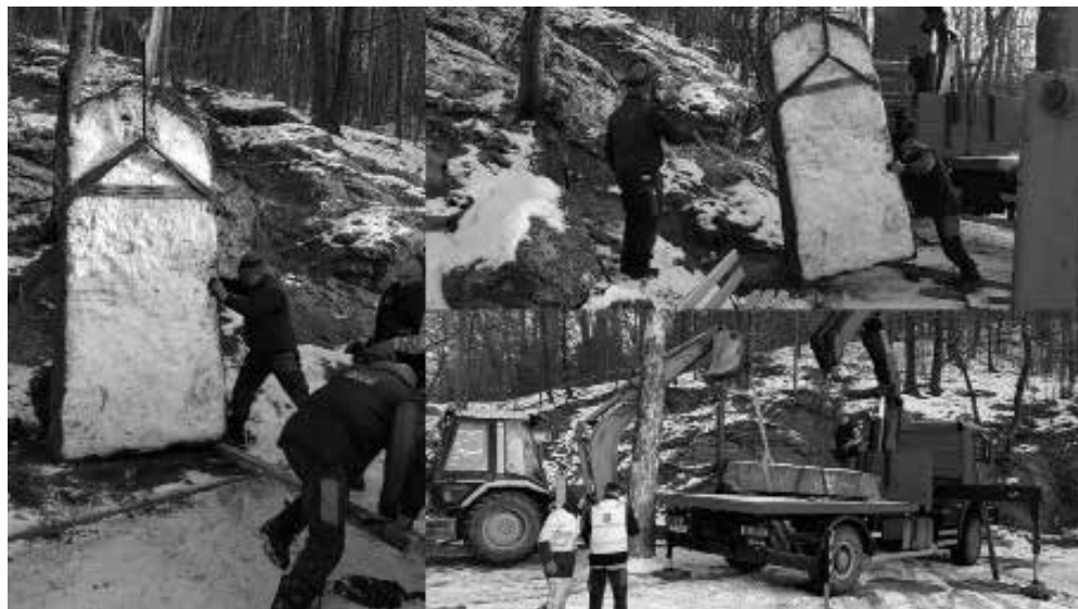
Ryc. 13. Prace przy ustawianiu płyty pomnika w Staniszowie
