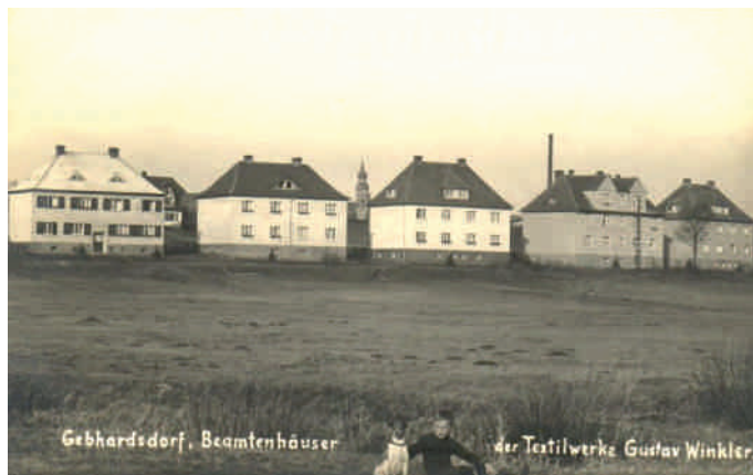
Osiedle Winklera, a w tle wieża giebułtowskiego kościoła.
