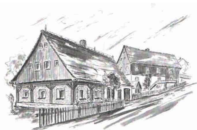
Giebułtów (Gebhardtsdorf) ausgemauertes Umgebendehaus mit leider untypischen neuen Fenstern Budynek przysłupowy z wymurowaniem i nietypowymi oknami
