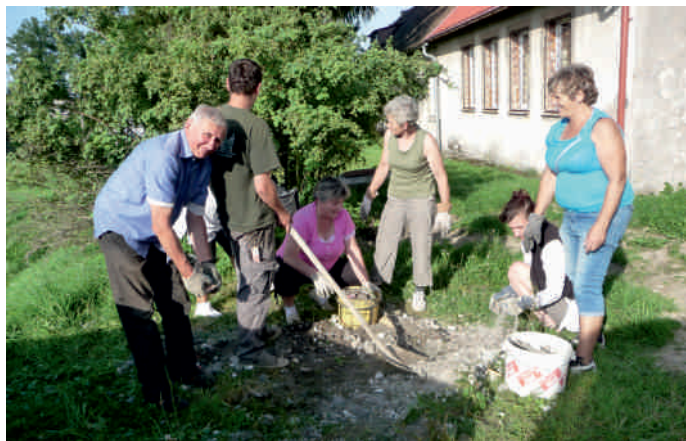
Prace porządkowe przy remizie
