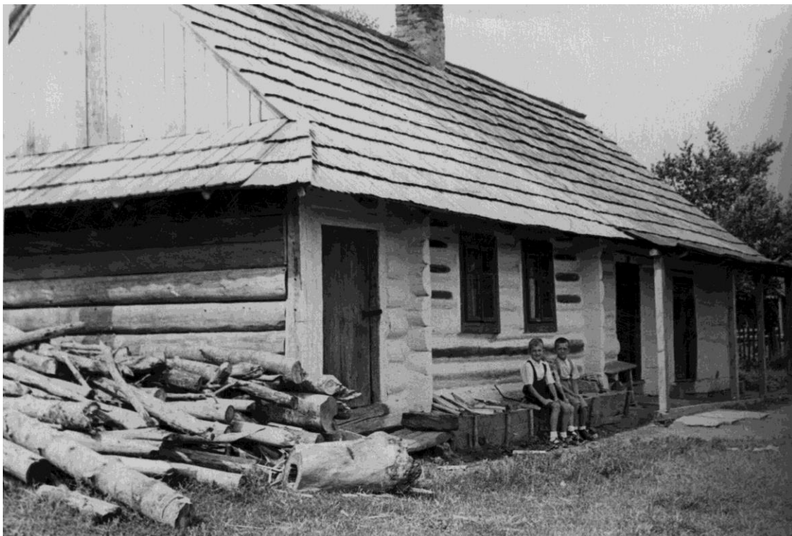
Nadyby 1957 r. Dom rodziny Sieradzkich po przebudowie
