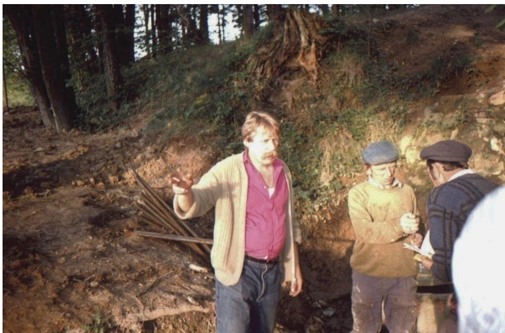
Podczas prac przy budowie wodociągu w 1993 r. Tadeusz Matusiewicz, Witold Ścisłowski, Ludwik Gandurski. Autor ks. Werner Macha
