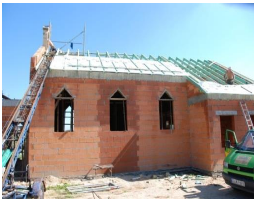
Budowa kaplicy cmentarnej w 2007 r. Autor Zbigniew Korobko
