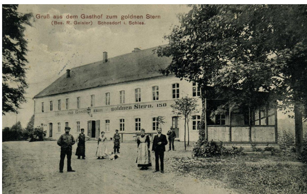
Gospoda Goldener Stern Paula Waltera. Obecnie świetlica wiejska „Pod Lotnikiem”
