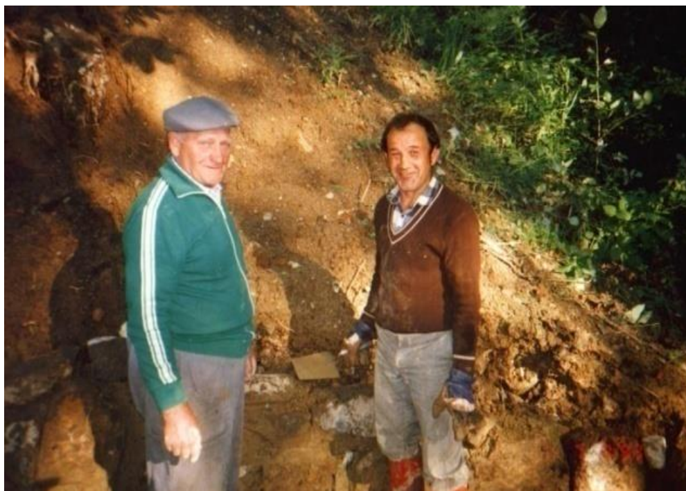
Prace przy wodociągu 1993. Kazimierz Brzozowski i Józef Kicuła. Autor ks. Werner Macha
