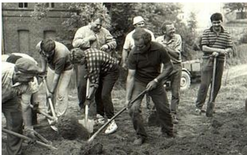
Podczas prac przy budowie wodociągu w 1993 r. Autor ks. Werner Macha
