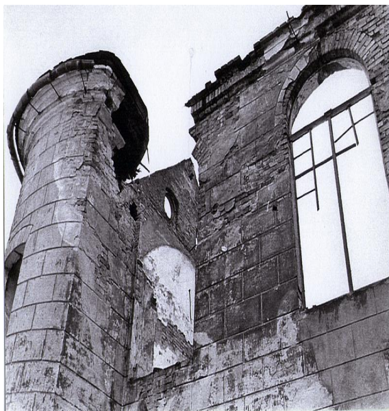
Fragment bryły kościoła ewangelickiego przed wyburzeniem.
