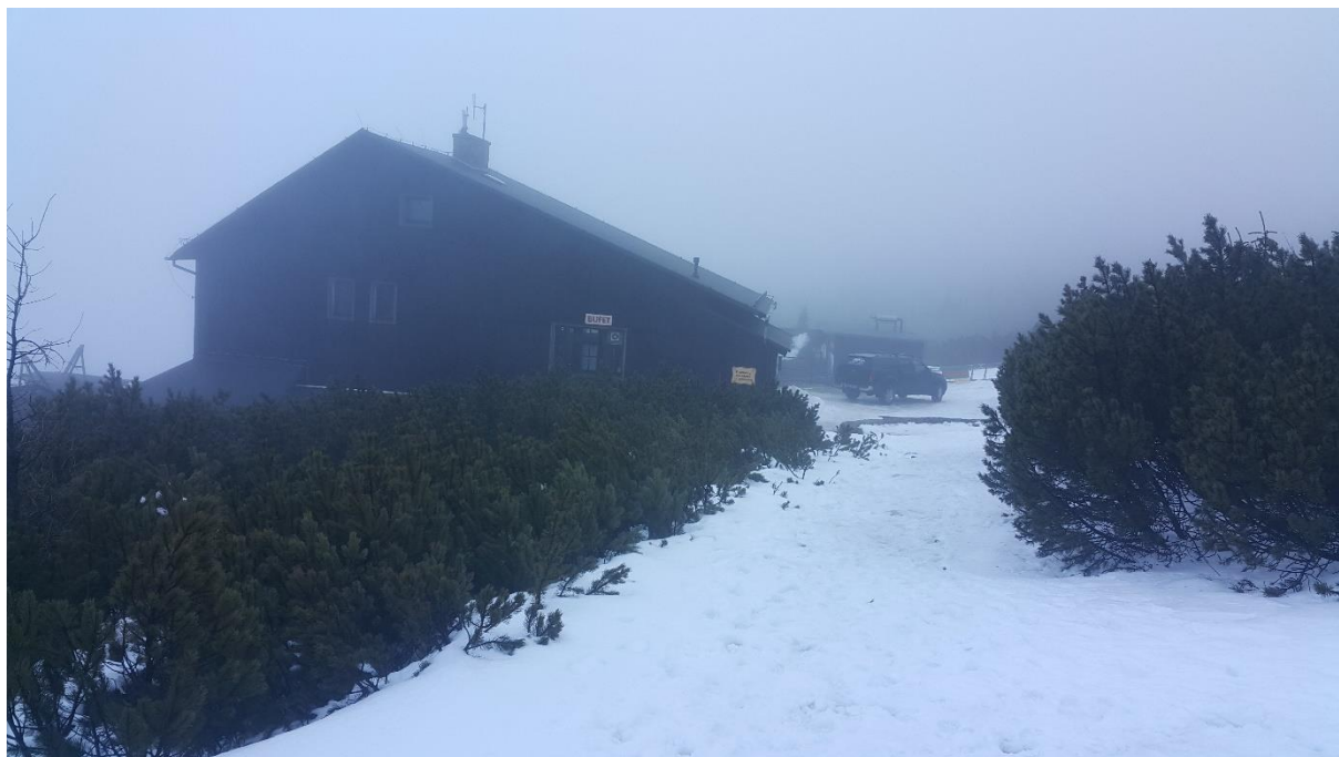
Górna stacja wyciągu na Kopę. Foto: Krzysztof Tęcza
