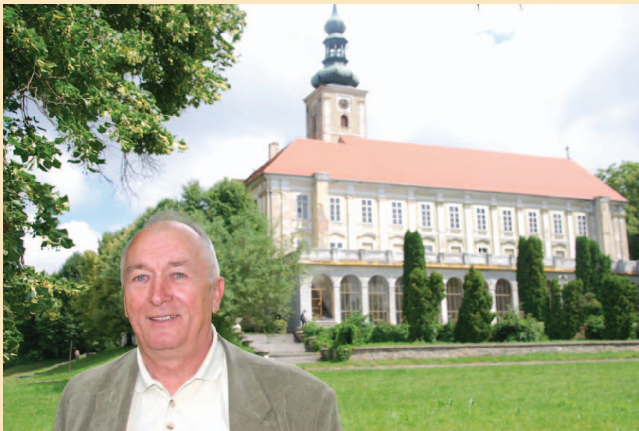
- Oczywiście będziemy własnym sumptem remontować, łątać, reperować, podmalowywać, ale to wszystko - mówi dyrektor Stefan Synowiec
