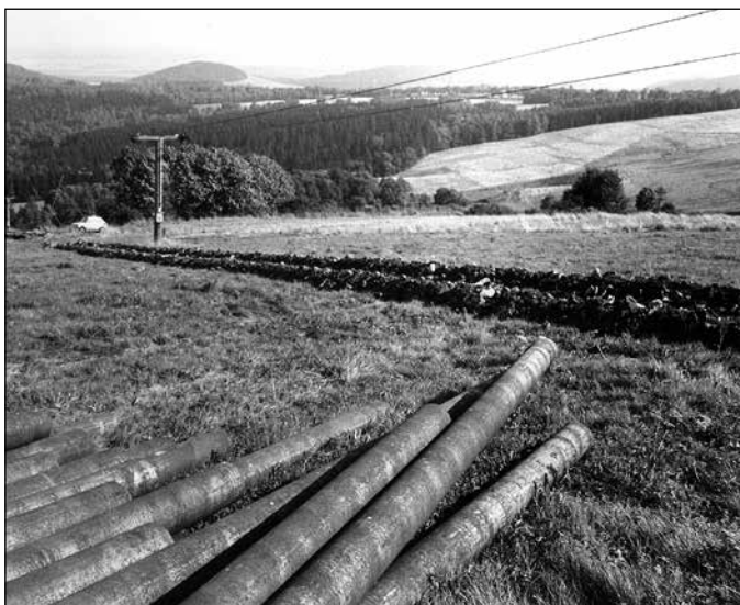
Budowa sztucznego naśnieżania – rury przygotowane do montażu, 1991 r.
