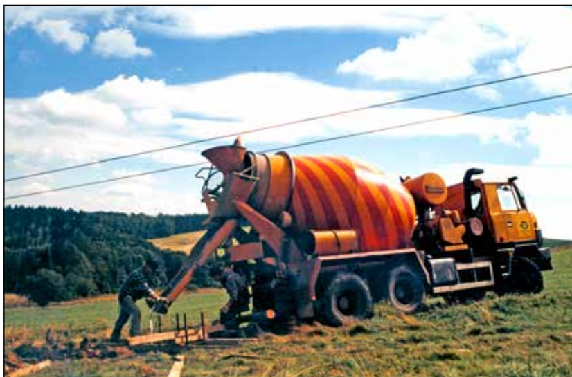
Wylewanie fundamentu pod Tatra – Pomę, 1997 r.
