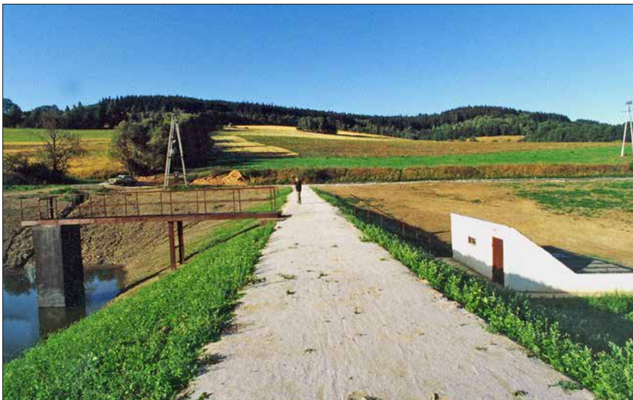
Zbiornik wody, zaporą – 1992 r.
