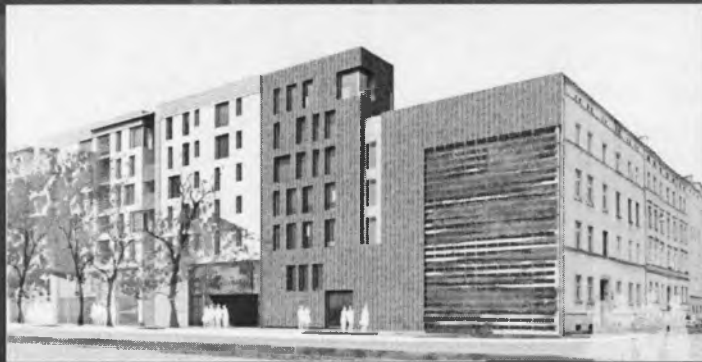
Budowa komunalnych budynków mieszkalnych – ul. Pułaskiego
