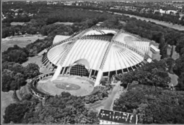
Renowacja Stadionu Olimpijskiego
