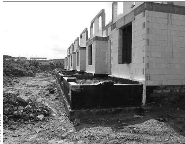
Ulica Królowej Elżbiety to strategiczna droga dla rozbudowującego się w tym rejonie osiedla domków jednorodzinnych - w głównej mierze budowanych obecnie przez Spółdzielnię Mieszkaniową w Świebodzi- cach
