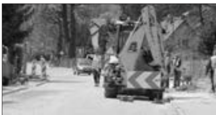
Ostatni element prac na ul. Mikulicza to przebudowa chodnika
