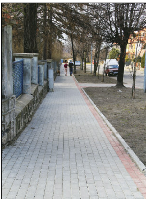
W ramach prac wykonano nową nawierzchnię po lewej stronie ulicy, kierując się w stronę Parku Miejskiego fot. Agnieszka Bielawska-Pękala
