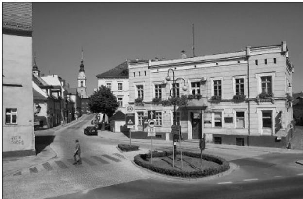
Budynek przy ul. Żeromskiego doczeka się remontu
