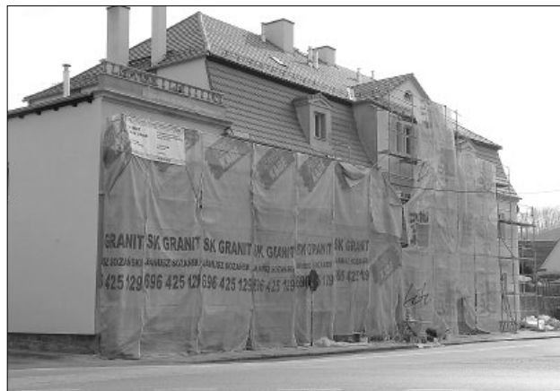
Kamienica na razie jest szczelnie przykryta rusztowaniami fot. Agnieszka Bielawska-Pękala
