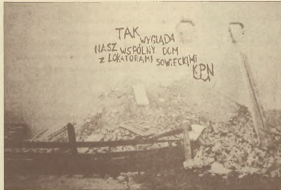
Napis na zrujnowanym budynku: „Tak wygląda nasz wspólny dom z lokatorami sowieckimi”
