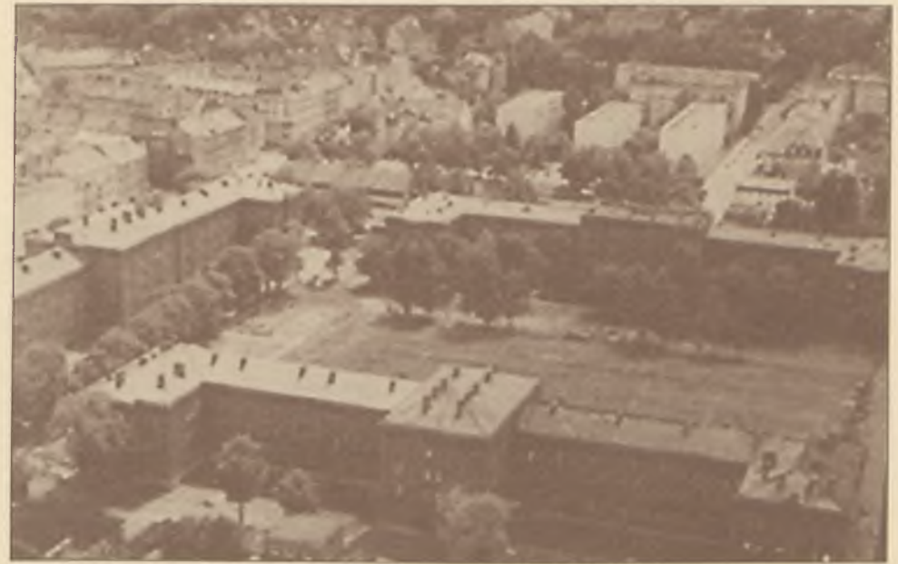
Kompleks koszarowy przy ul. Hutników
