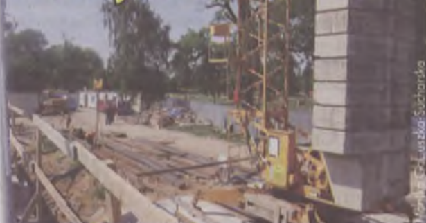
Budowa basenu w Oławie powoli zmierza do szczęśliwego końca
