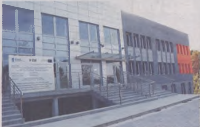
Zmodernizowany budynek przychodni SP ZOZ przy ulicy Baczyńskiego 1
