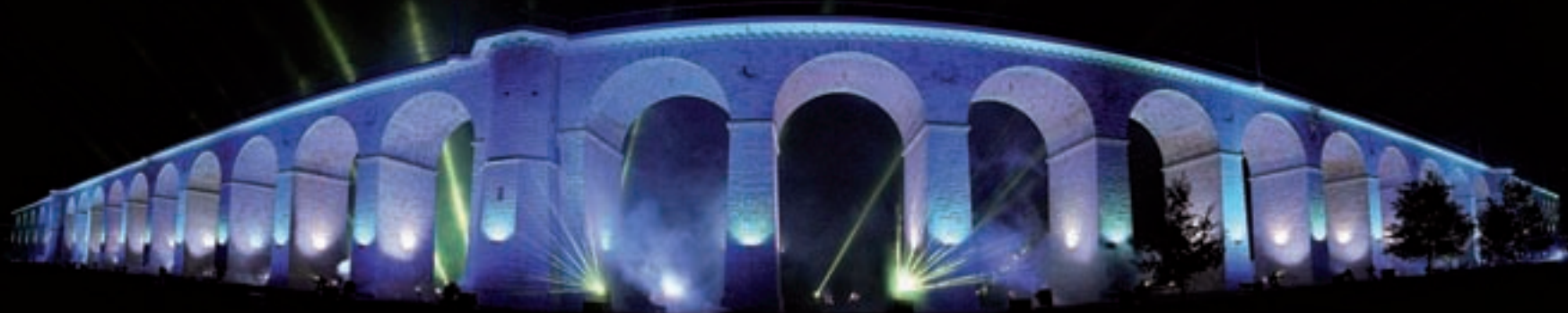
Wiadukt kolejowy nad rzeką Bóbr
