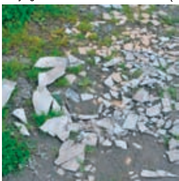
Azbestowe płyty leżą na drodze.
