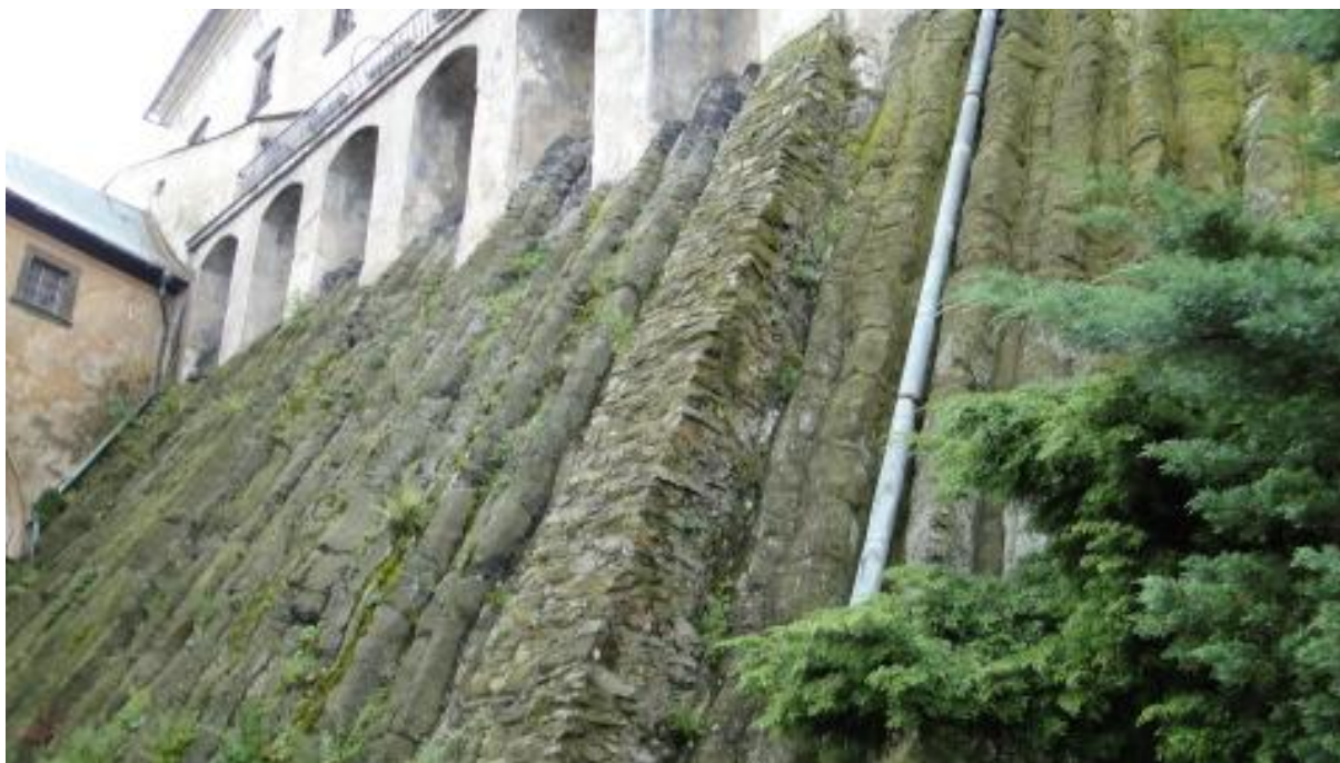
Bazaltowe skały, na których wsparto mury zamku we Frydlancie. Foto: Krzysztof Tęcza
