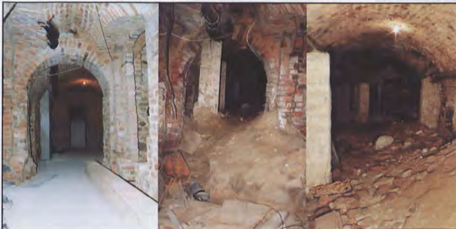
Tak wyglądały wnętrza Winiarni przed remontem i w jego trakcie.
