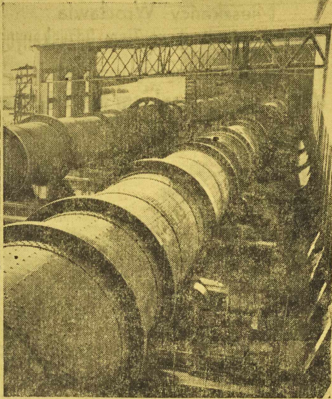
PROJEKT cementowni wykonano Leningradzkie Biuro Projektów „Giprocement“. Głównym projektantem jest jeden z najlepszych fachowców radzieckich — inżynier Iwan Jeżow. Wszystkie urządzenia pochodzą z dostaw radzieckich. Długość pieców i technika urządzeń stawia ten zakład w rzędzie najnowocześniejszych zakładów w Europie. — Na zdjęciu: fragment pieców obrotowych. CAF — Fot. Baranowski
