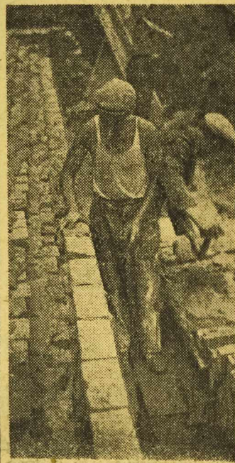
DWÓJKA murarska Ryszarda Rajzy pracująca przy budowie Młynowa, ustanowiła w dniu 20. 8. br. nowy rekord murarski w systemie dwójkowym, kładąc w ciągu 7 i pół godziny pracy 22.272 cegły.
