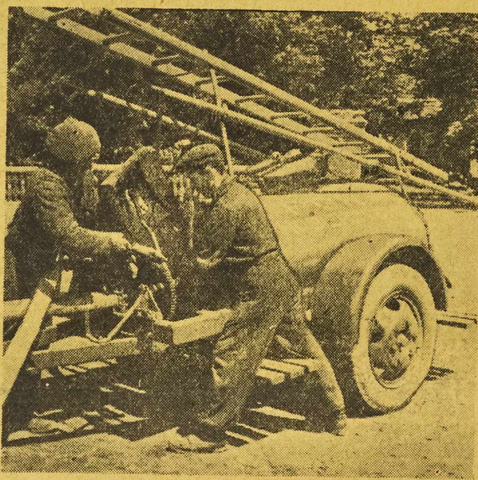
PRACOWNICY PGR KOBIERZYCKO MONTUJĄ MOTO-POMPE
