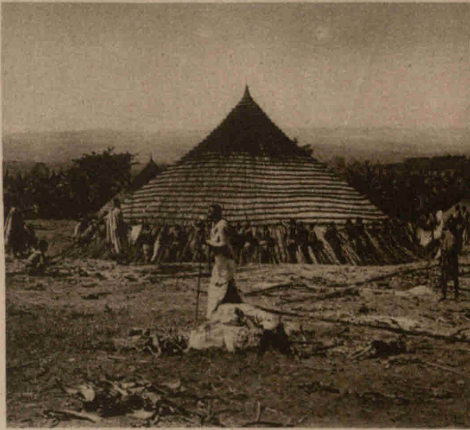
Hausbau der Eingeborenen in Deutsch-Ostafrika
