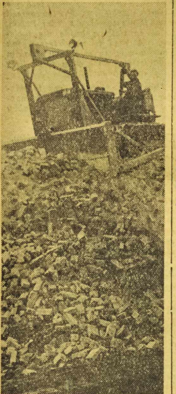
Założono pierwsze fundamenty, położono pierwsze cegły. Pełne poświęcenia i entuzjazmu brygady robotnicze nawiązały współwzajemność, by budować, szybciej, lepiej i oszczędnie.
