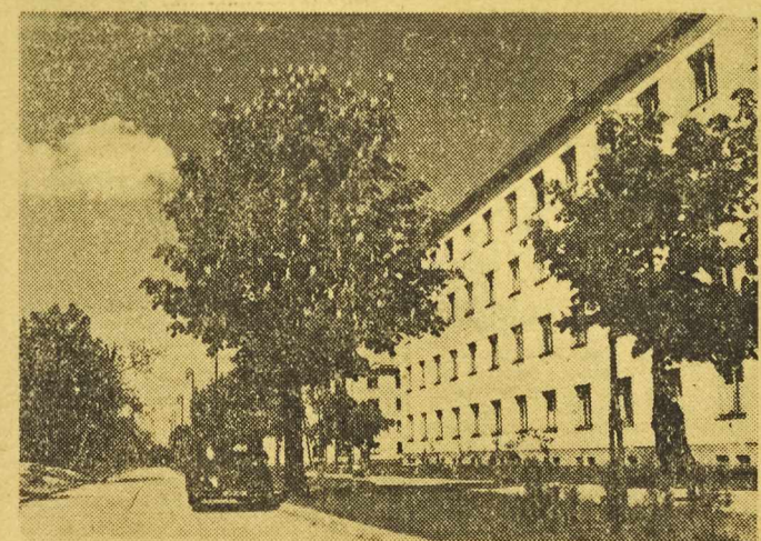
Fragment osiedla mieszkaniowego na Żoliborzu w Warszawie. (CAF — fot. Tyminski)
