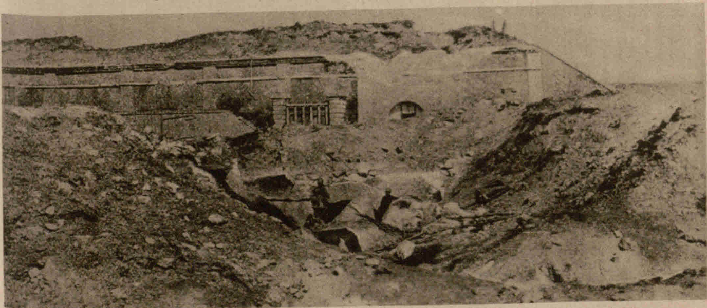
Wie der Eingang zum Fort de Vaux bei Verdun unter der Einwirkung des deutschen Feuers aussieht
