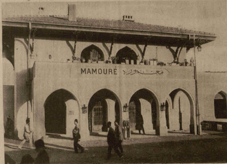
Typisches Stationsgebäude der Bagdadbahn (am Amanusgebirge) Phot. Zabel Die charakteristische morgenländische Bauform ist in glücklicher Weise dem technischen Zweck angepaßt
