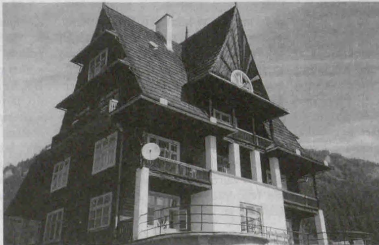
Schronisko „Trzy Korony” w Sromowcach Niżnych. Foto: Andrzej Matuszczyk
