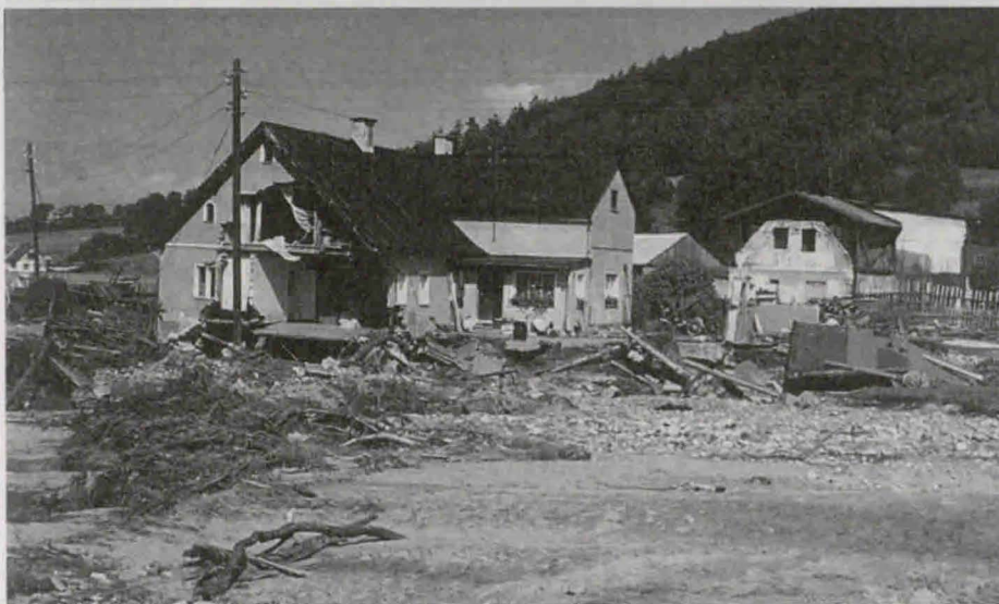
Radochów. Tędy przeszła fala uderzeniowa z pękniętego wału. Foto: Radosław Siekierzyński
