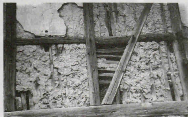
„Przejrzysty” obraz istoty konstrukcji szachulcowej – chałupa w Siedlęcinie koło Jeleniej Góry
