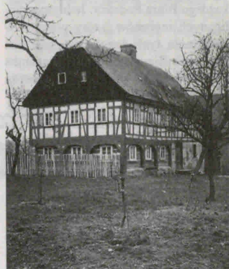
Malowicze połączenie konstrukcji przysłupowej i szachulcowej – chałupa na polskich Łużycach: Wolimierz na Pogórze Izerskim
