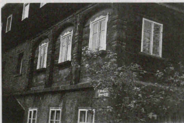
Częściowo już tylko zachowana konstrukcja przysłupowa – dom w łużyckim mateczniku: Chróścicy koło Budziszyna
