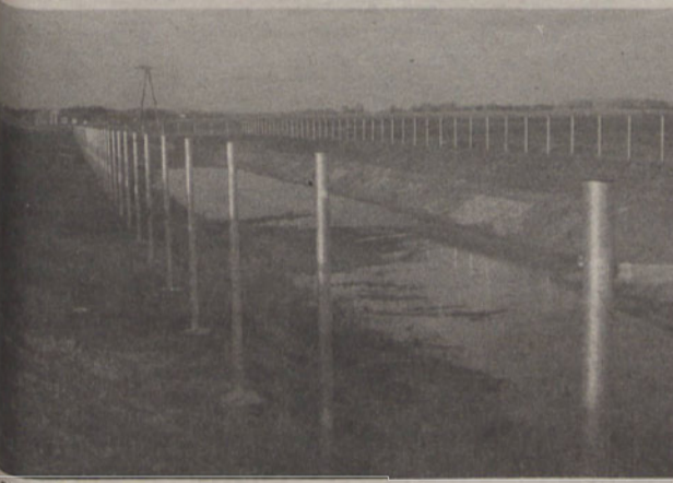
Po płocie zostały słupki i kilkanaście przęsła
