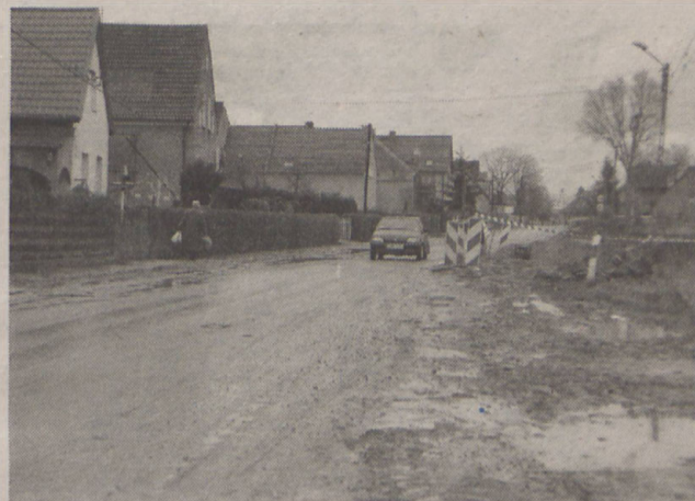
Gdy tylko popada deszcz przy niektórych drogach praktycznie nie da się przejść
