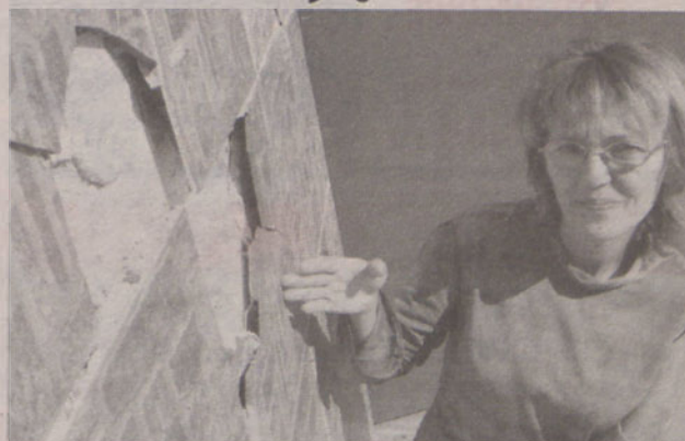
Mariola Kluczyńska pokazuje zniszczoną elewację budynku
