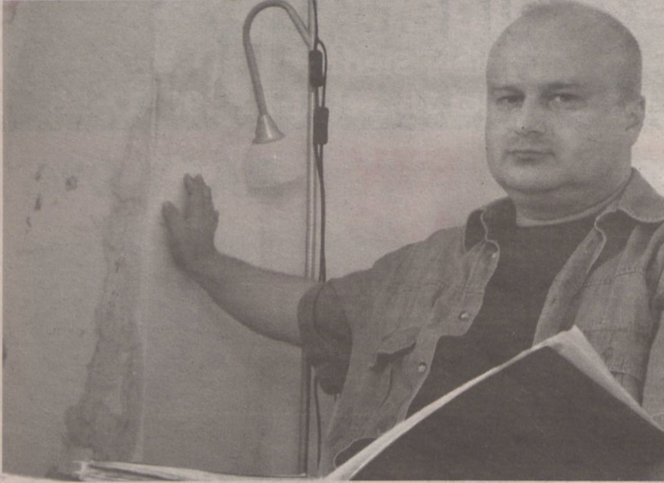
- Wystarczy dzień deszczu, aby na ścianach tworzyły się zacieki – mówi Hubert Dziubich, lokator z poddasza
