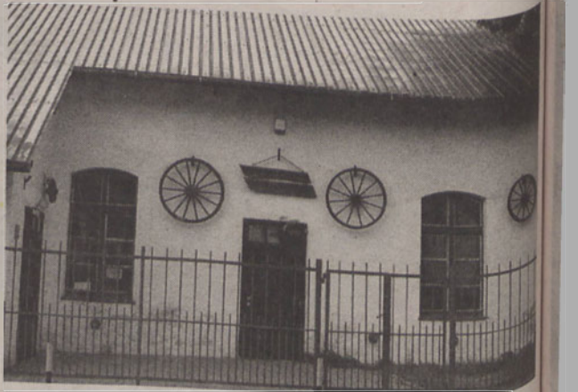
Rozpoczęły się przygotowania do adaptacji poddasza świetlicy w Żernikach Wrocławskich. Prace potrwać do końca maja przyszłego roku. Placówka będzie więc nieczynna przynajmniej przez kilka miesięcy. Koszt całej inwestycji wyniesie ok. 388 tys. zł.
