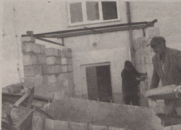
Pod koniec sierpnia trwały ostatnie prace przy odnawianiu tylnego wejścia do siechnickiej szkoły
