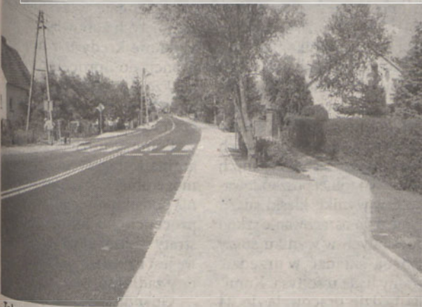
Tak teraz wygląda przebudowana droga w Tyńcu Małym...
