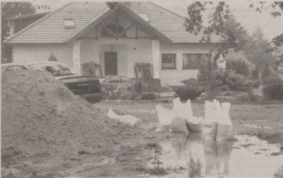
Na szczęście woda na Osiedlu Okrzei nie wdarła się do domów
