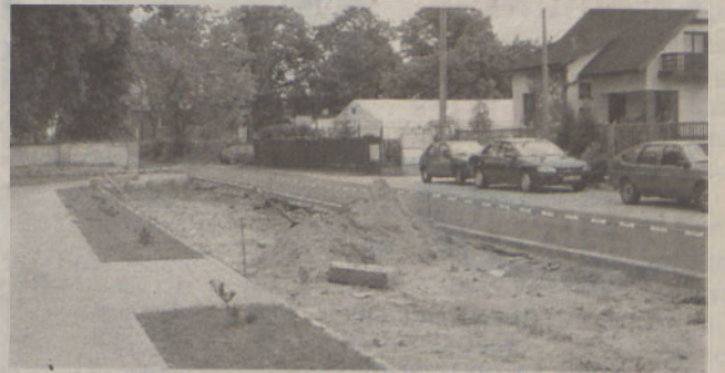
Prace drogowe są realizowane na terenie całej gminy
