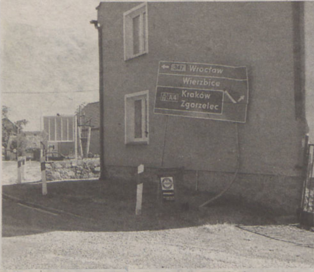
Jak jest niebezpiecznie widać choćby po pogiętym znaku drogowym
