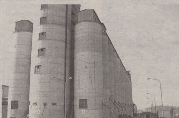
Obok betonowego elewatora powstanie sześć metalowych zbiorników
