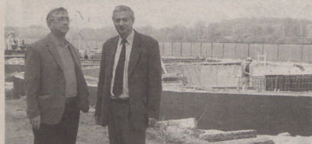
Kierownik Sławek Kończarek i wójt Stanisław Susło na tle fundamentów zbiorników
