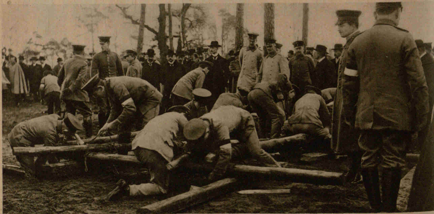
Das Zusammenfügen und Ausbauen einer improvisierten Brücke
