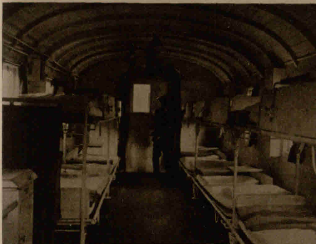
Links: Ein Krankentransportwagen. Die Krankenbetten, die gleichzeitig als Traggähren verwendet werden können, ruhen auf federnden Gestellen, so daß der Kranke keiner Erschütterung ausgesetzt ist. Rechts: Der Operationswagen
